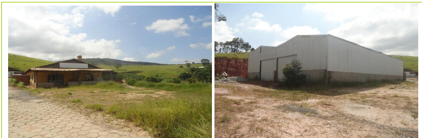
Figura 125: Benfeitorias inutilizáveis da segunda propriedade situada na Área 01 da AID da Pedreira Lebourg.
