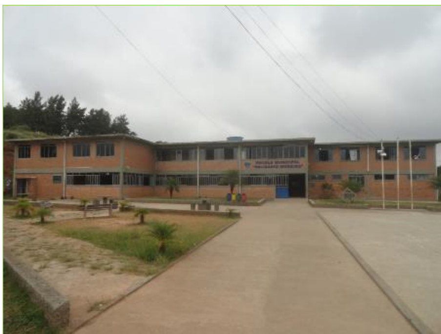
Figura 135: Escola Municipal Belisário Moreira. Coordenadas: 628.380 m E / 7.669.993 m S.
