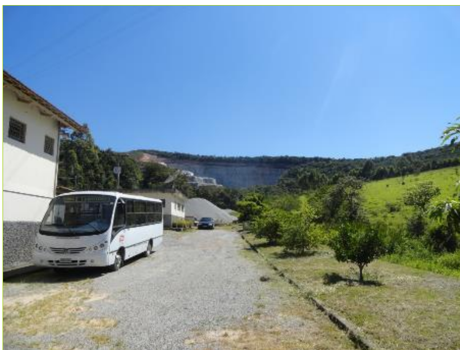
Figura 34: Paisagem local, tomada a partir de ponto ao lado do escritório. À direita observa-se a calha fluvial do único córrego que drena a área do empreendimento, o qual não tem identificação. Parte das estruturas que se vê na fotografia estão inseridas em APP,
