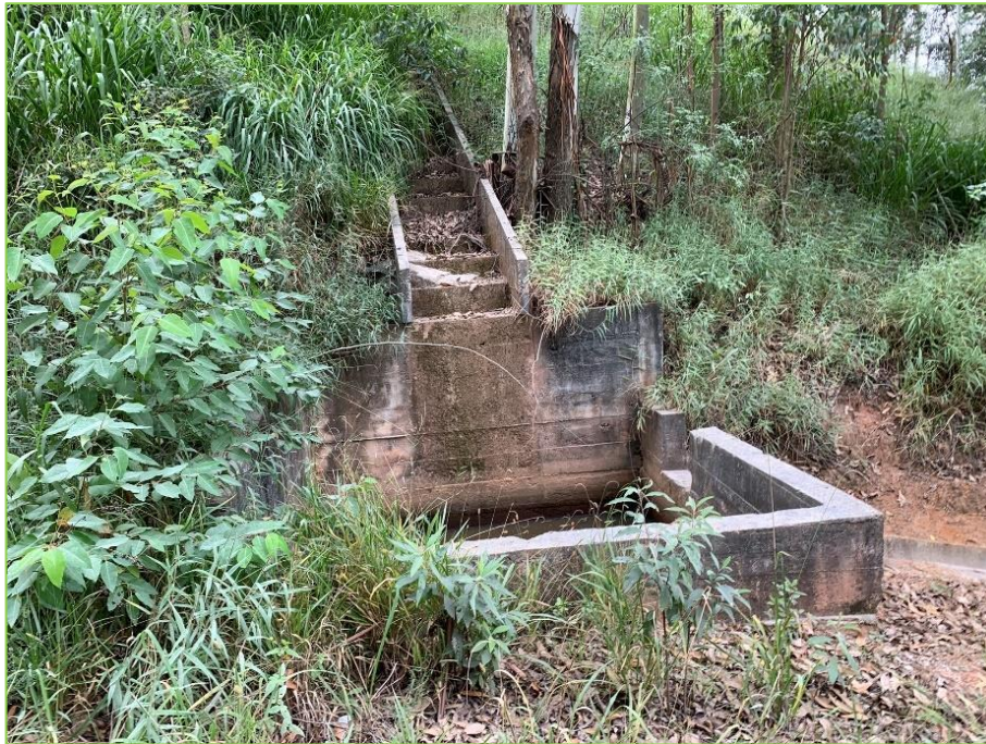
Figura 15: Exemplo de escada hidráulica instalada no talude da pilha de estéril reabilitada, com caixa de contenção de alvenaria e canaleta de drenagem.
