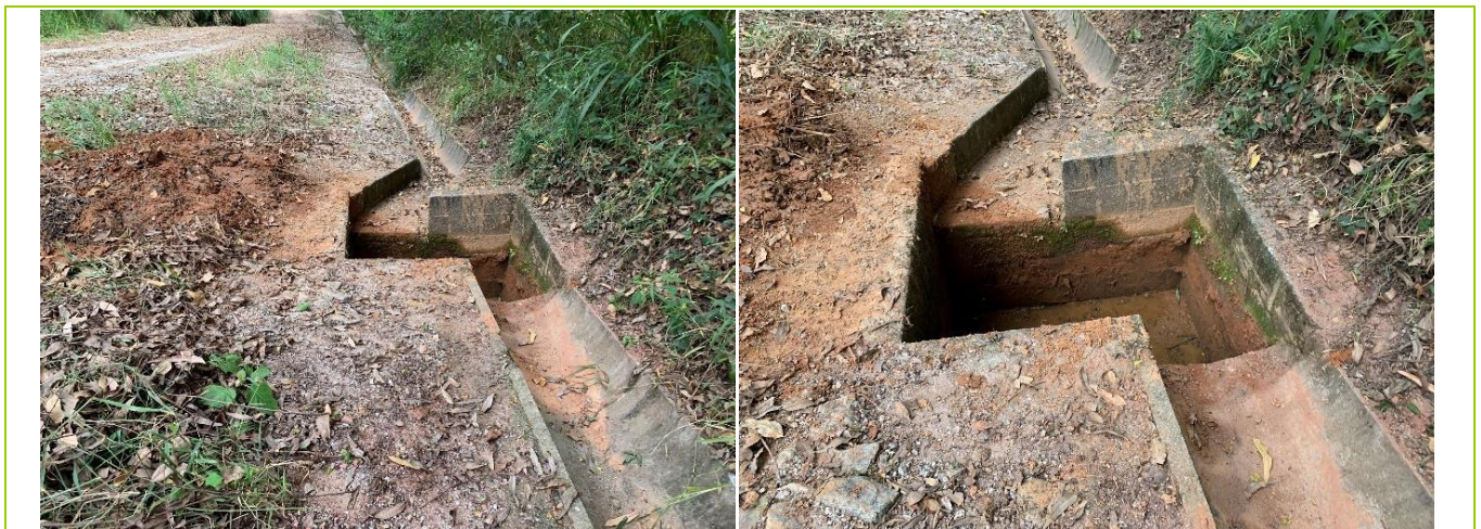
Figura 14: Exemplo das Canaletas de drenagem pluvial, com caixas de contenção de alvenaria instaladas nas laterais de uma das vias de acesso interno da empresa (via lateral da pilha de estéril desativada e reabilitada do empreendimento).
