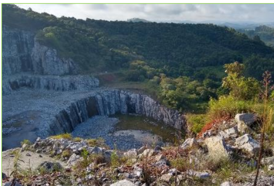
Figura 69: Ponto AV09 – Área de Lavra – Cava.
