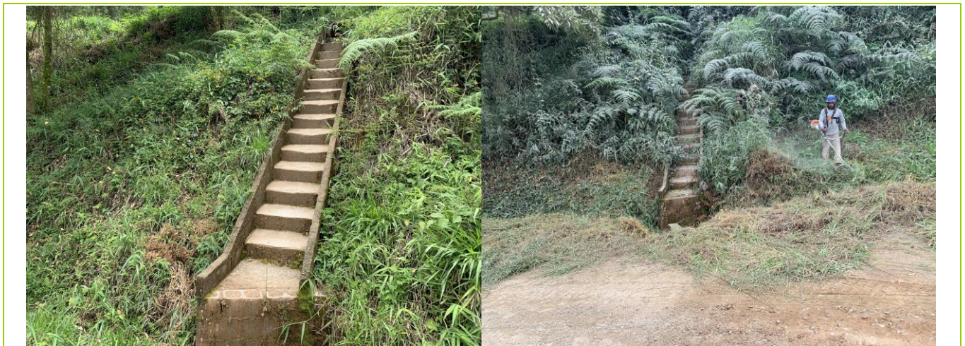
Figura 16: Exemplos de escadas hidráulicas, acompanhadas de bacia de contenção em alvenaria e manilha de passagem instalada nos taludes do imóvel.
