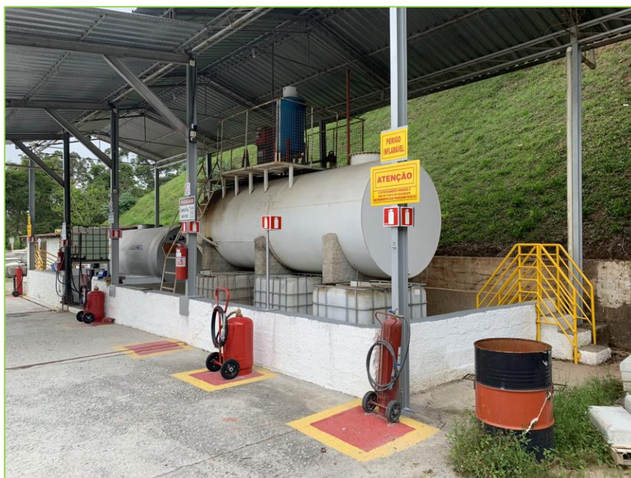
Figura 10: Ponto de Abastecimento da Lebourg.
