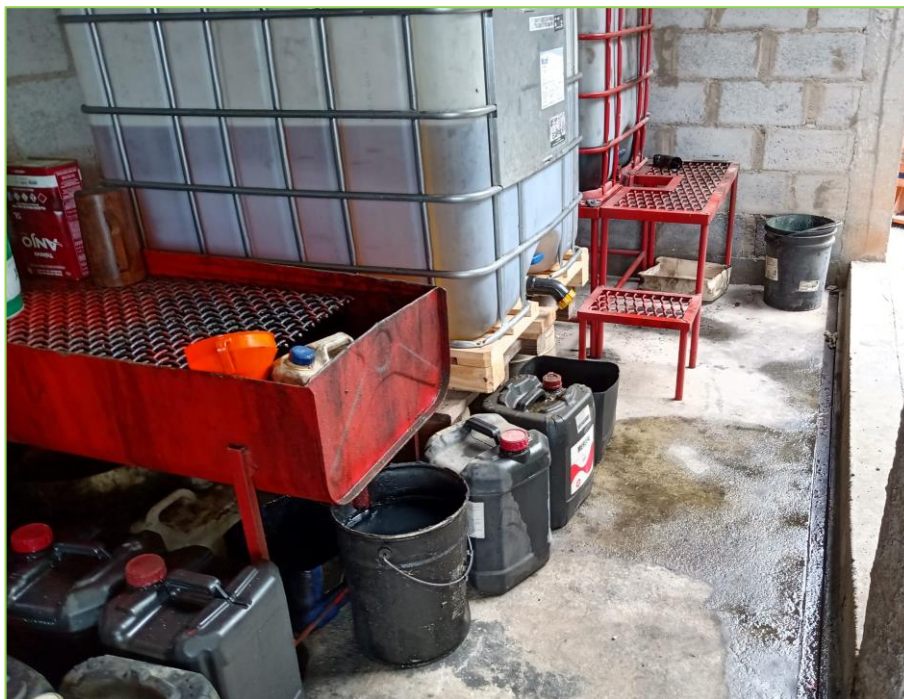
Figura 23: Ilustração do depósito de resíduos perigosos da empresa, com acondicionamento dos resíduos oleosos. O local é coberto, com piso de concreto e dotado de canaletas de drenagem oleosa, que direcionam o efluente que eventualmente for derramado para a Caixa Separadora de água e óleo do empreendimento.
