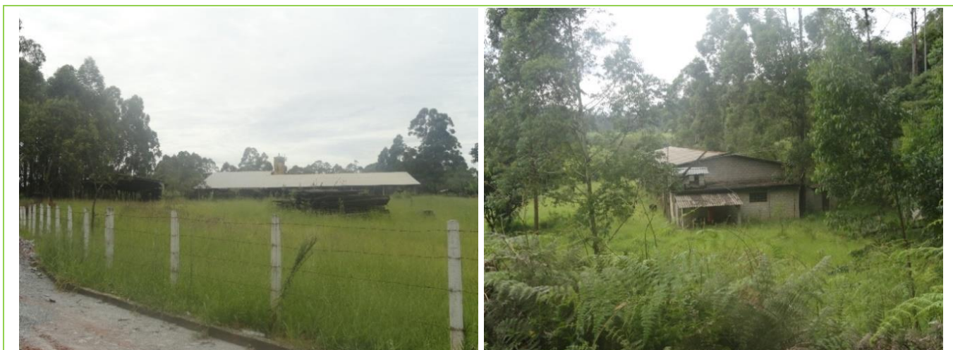
Figura 126: Edificações existentes na propriedade situada na Área 02 da AID; nota-se o estado de abandono das mesmas.
