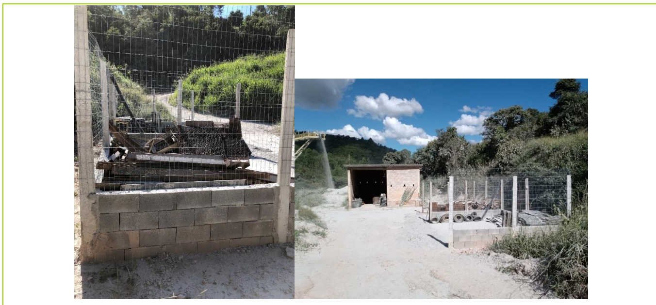
Figura 24: Ilustração dos locais de armazenamento de resíduos industriais não contaminados, recicláveis ou reutilizáveis.
