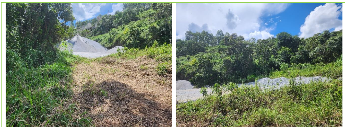
Figura 108: Outro registro fotográfico da Área de Intervenção de 01.
