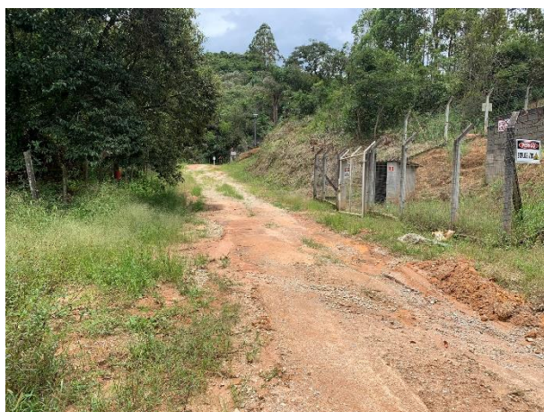
Figura 110: Registro fotográfico atual da Área de Intervenção 05 que engloba um trecho da estrada antiga que dá acesso aos paíóis de explosivos e acessórios.
