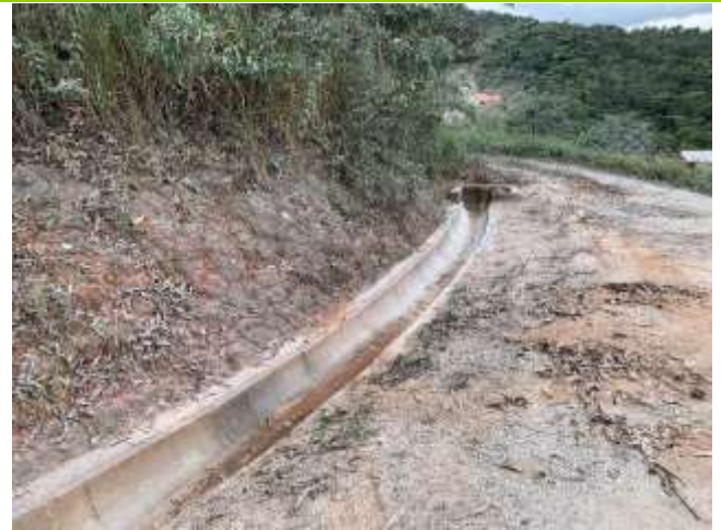
Figura 6: Exemplo das Canaletas de drenagem pluvial instaladas nas laterais de uma das vias de acesso interno da empresa (via próxima a área de abastecimento do britador primário).
