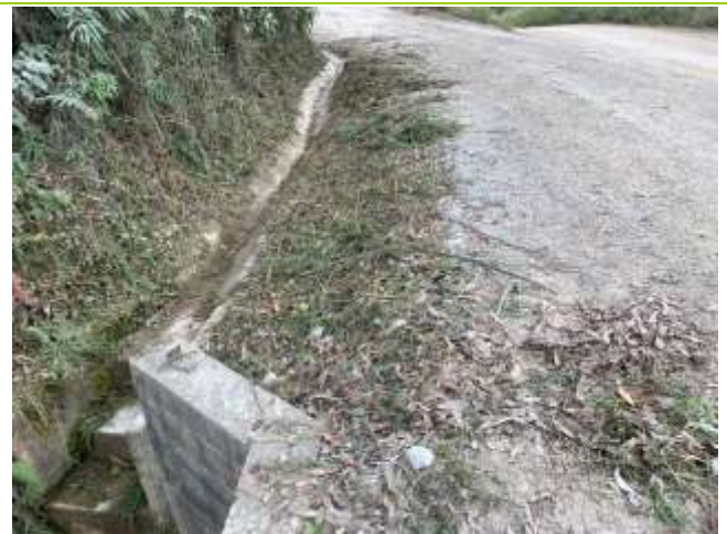
Figura 7: Exemplo das Canaletas de drenagem pluvial, com caixas de contenção de alvenaria instaladas nas laterais de uma das vias de acesso interno da empresa (via de acesso entre a área de lavra e área de abastecimento do britador primário).
