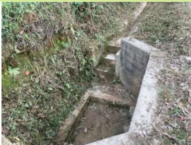
Figura 7: Exemplo das Canaletas de drenagem pluvial, com caixas de contenção de alvenaria instaladas nas laterais de uma das vias de acesso interno da empresa (via de acesso entre a área de lavra e área de abastecimento do britador primário).
