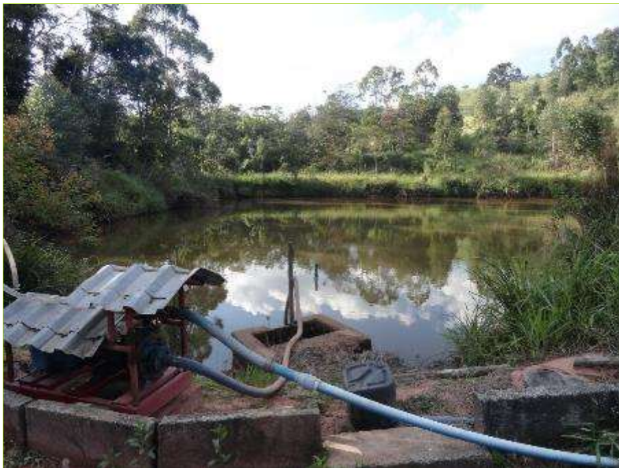
Figura 50: Reservatório formado a partir do barramento do Córrego A. (coordenadas UTM: 628.943 m E / 4.995.956 m S).
