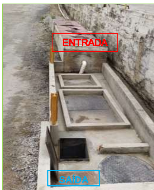
Figura 18: Sistema de tratamento de efluentes industriais (Caixa Separadora de Água e Óleo) do empreendimento.
