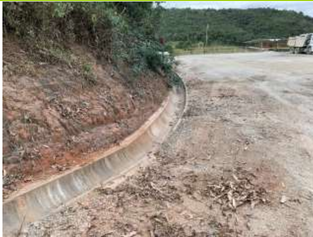
Figura 6: Exemplo das Canaletas de drenagem pluvial instaladas nas laterais de uma das vias de acesso interno da empresa (via próxima a área de abastecimento do britador primário).
