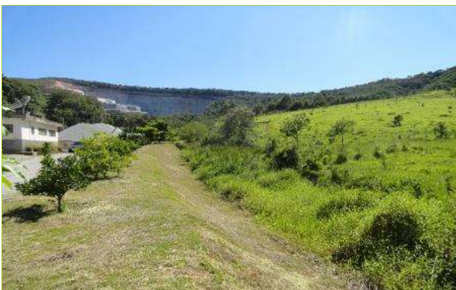
Figura 49: Trecho final da calha fluvial do Córrego B, próximo ao escritório. Ao fundo a visão da Mina 1. (coordenadas UTM: 629.337 m E / 7.666.021 m S).
