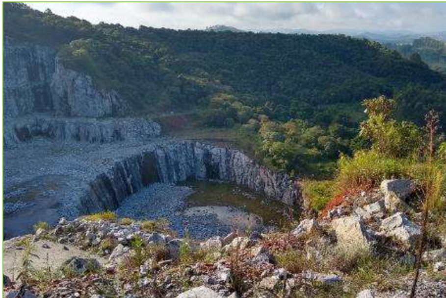
Figura 39: Ponto AV09 – Área de Lavra – Cava.
