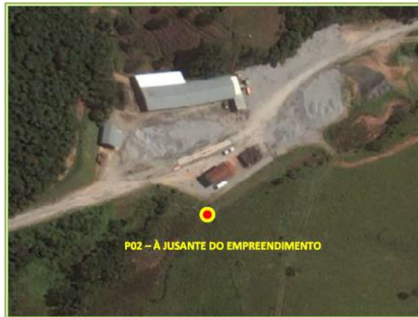
Figura 63: Ponto de amostragem de água, no Ribeirão Afluente do Córrego do Paulino, à jusante do empreendimento.
