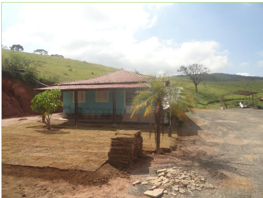
Figura 90: Residência da segunda propriedade situada na Área 01 da AID da Pedreira Lebourg.
