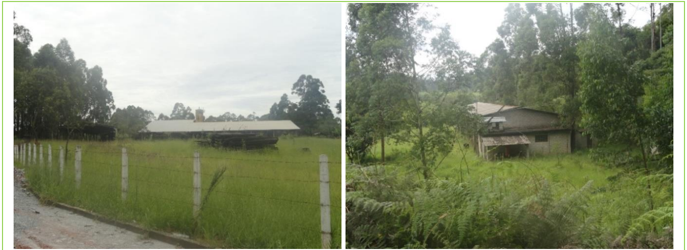
Figura 92: Edificações existentes na propriedade situada na Área 02 da AID; nota-se o estado de abandono das mesmas.
