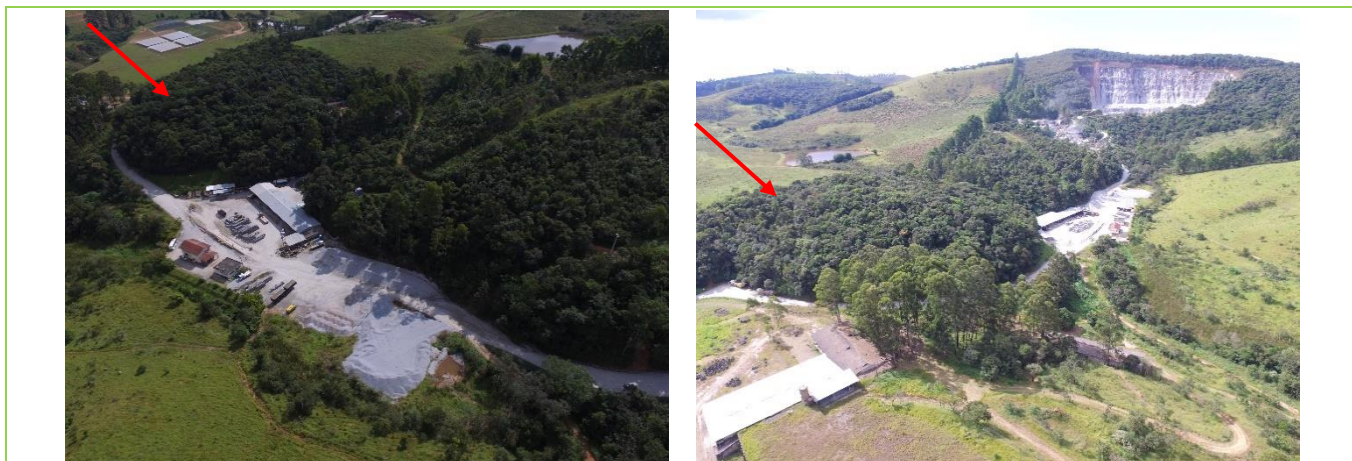
Figura 57: Imagens aéreas da Gleba 1 a localização desta em relação a atividade da empresa (extração de rochas). Imagens drone, maio/23.
